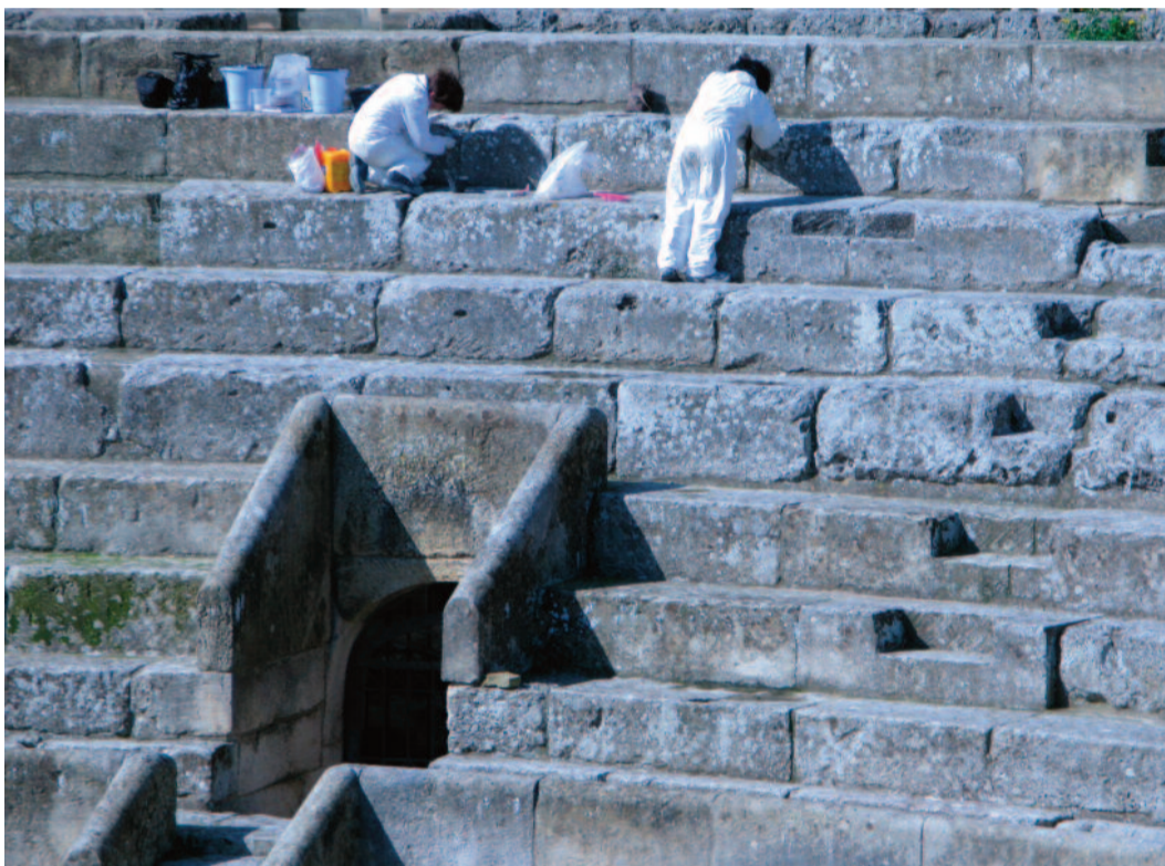
Lavori di pulizia delle pietre dell’Anfiteatro di Piazza Sant’Oronzo, nell’agosto del 2012
